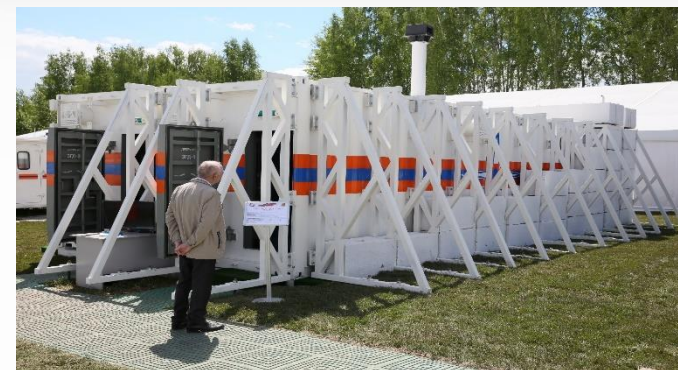
Защитное сооружение гражданской обороны блок – модульного типа полной заводской готовности «Куб-М»
